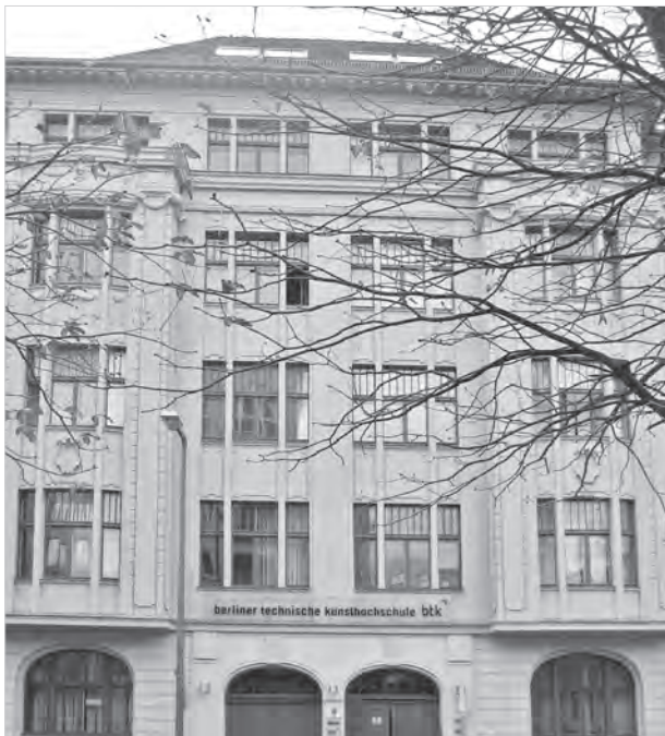
Abb. 1: Das Gebäude Bernburger Str. 24/25, heute Sitz der Berliner Technischen Hochschule
